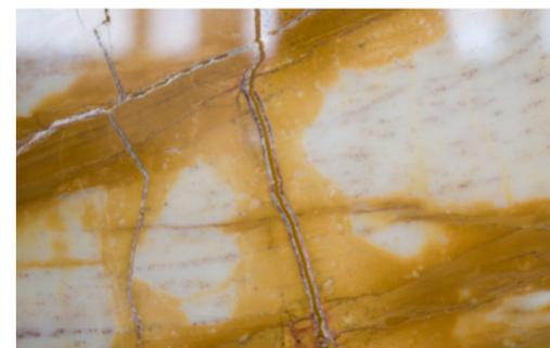
resinatura fessura (dettaglio) - slit resin coating (detail)
